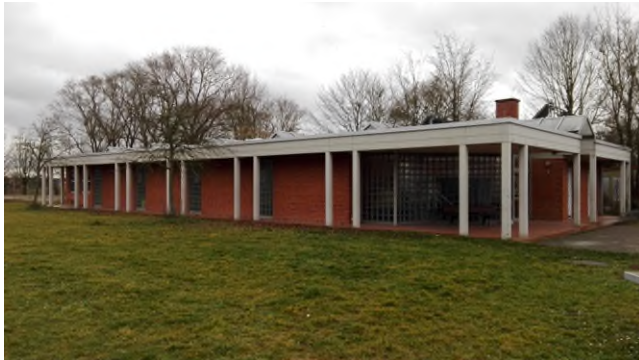
Sportanlage Hähnlein, Sanierung Funktionsgebäude 500.000 €
