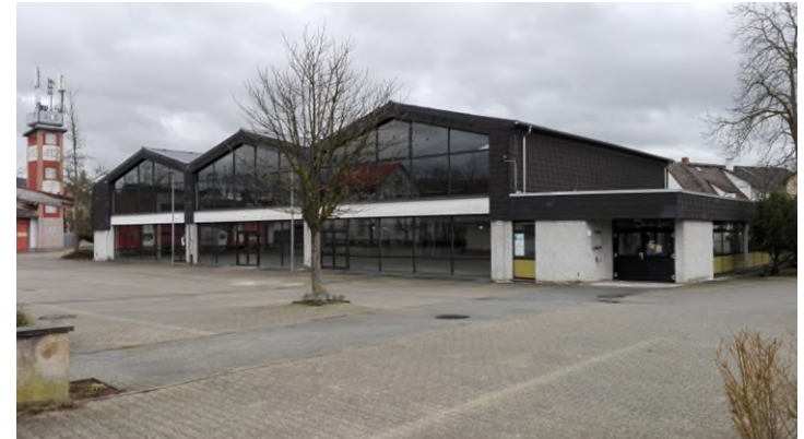
Sport- und Kulturhalle, Sanierung
